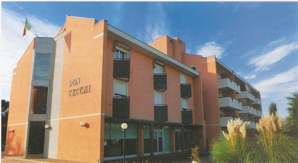
CENTRO DON VECCHI 3 via Carrara 10 Marghera - Ve 57 ALLOGGI
